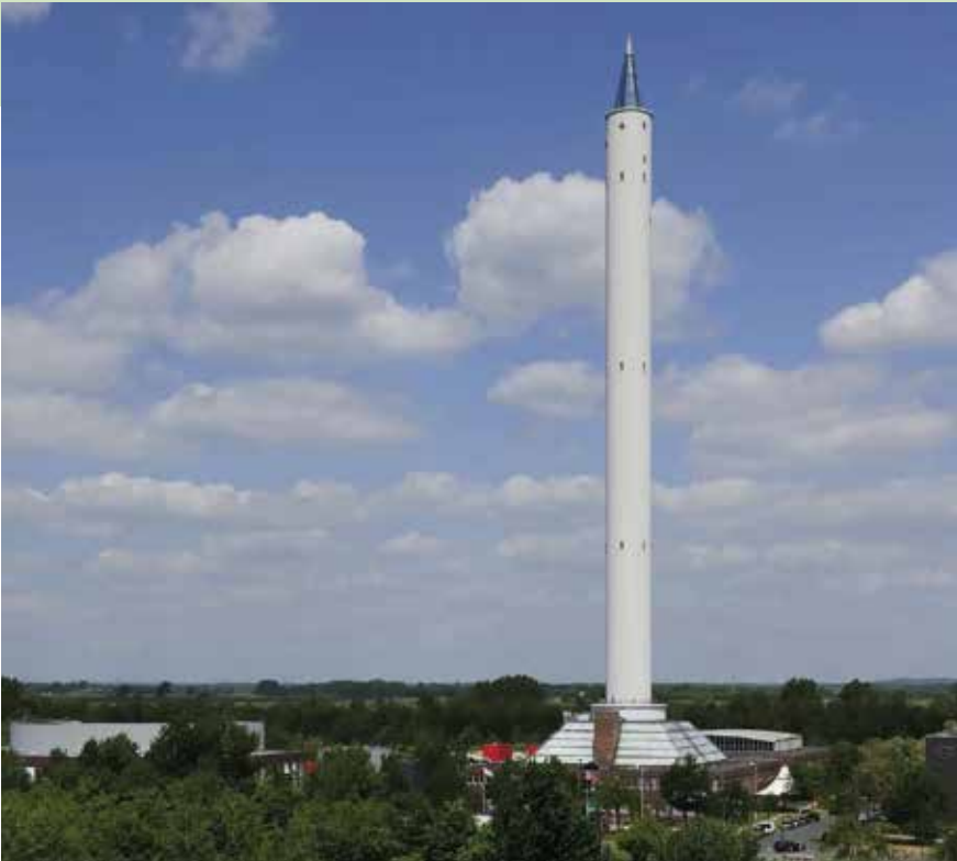
Der Fallturm Bremen, der vom ZARM betrieben wird. Er macht erdgebundene Experimente unter Schwerelosigkeit möglich.
