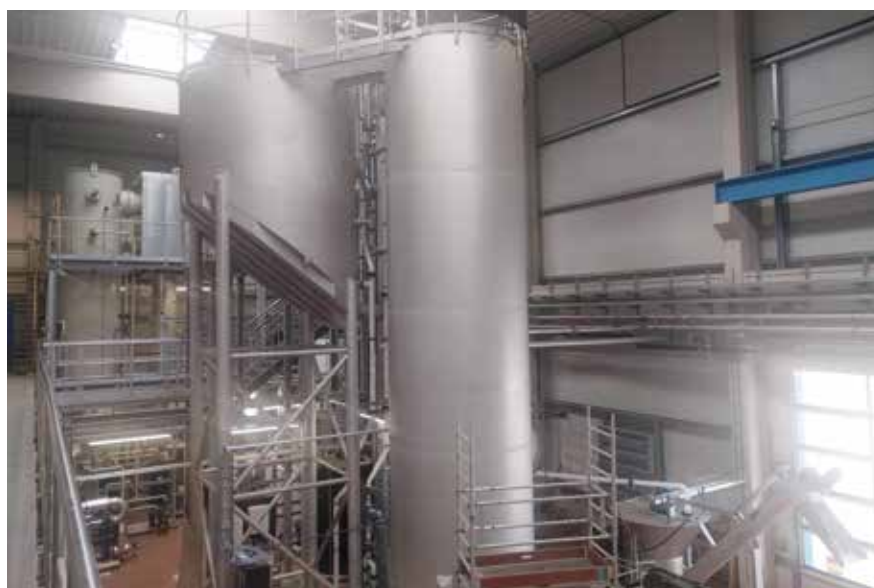
In diesem Reaktor der MAP-Anlage wird der Phosphor gefällt.
