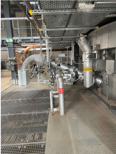
Lanze zum Anheizen des Wirbelschicht- ofens
