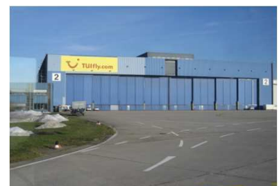
Wartungshalle der TUI
