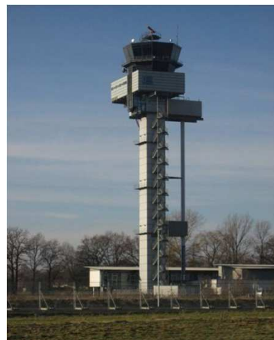
Der neue Tower 3
