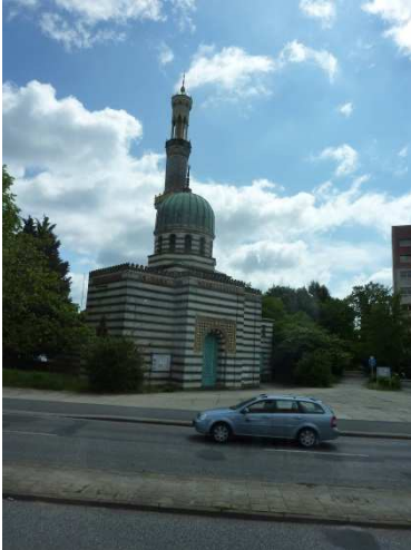
Pumpwerk (Moschee) Foto: R.-R. Remus
