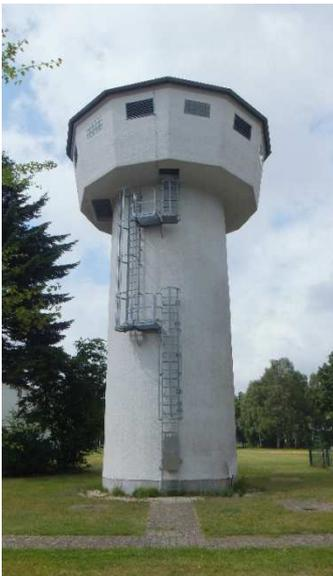
Mischturm für das aus fünf Horizontal-Filterbrunnen geförderte Wasser
