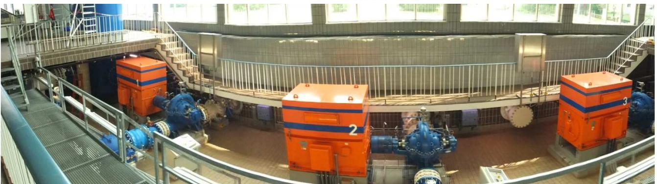
Die Spitzenleistung dieser 3 drehzahlgeregelten Kreiselpumpen beträgt 85.000 m³ pro Tag
