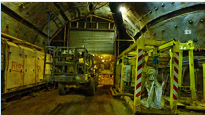
Baustelle im Schacht Konrad
