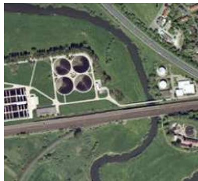
Das kleinere Klärwerk Herrenhausen
