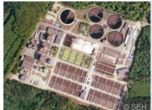
Das größte Klärwerk Niedersachsens-Gümmerwald (165.000 m 3 pro Tag)
