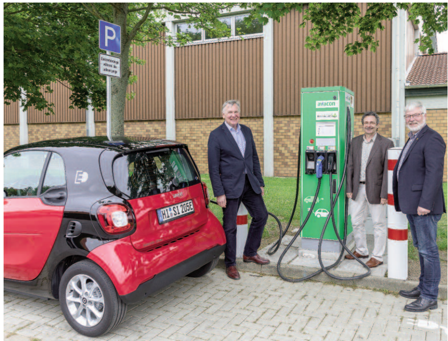
Inbetriebnahme einer Schnellladesäule in Schellerten.
