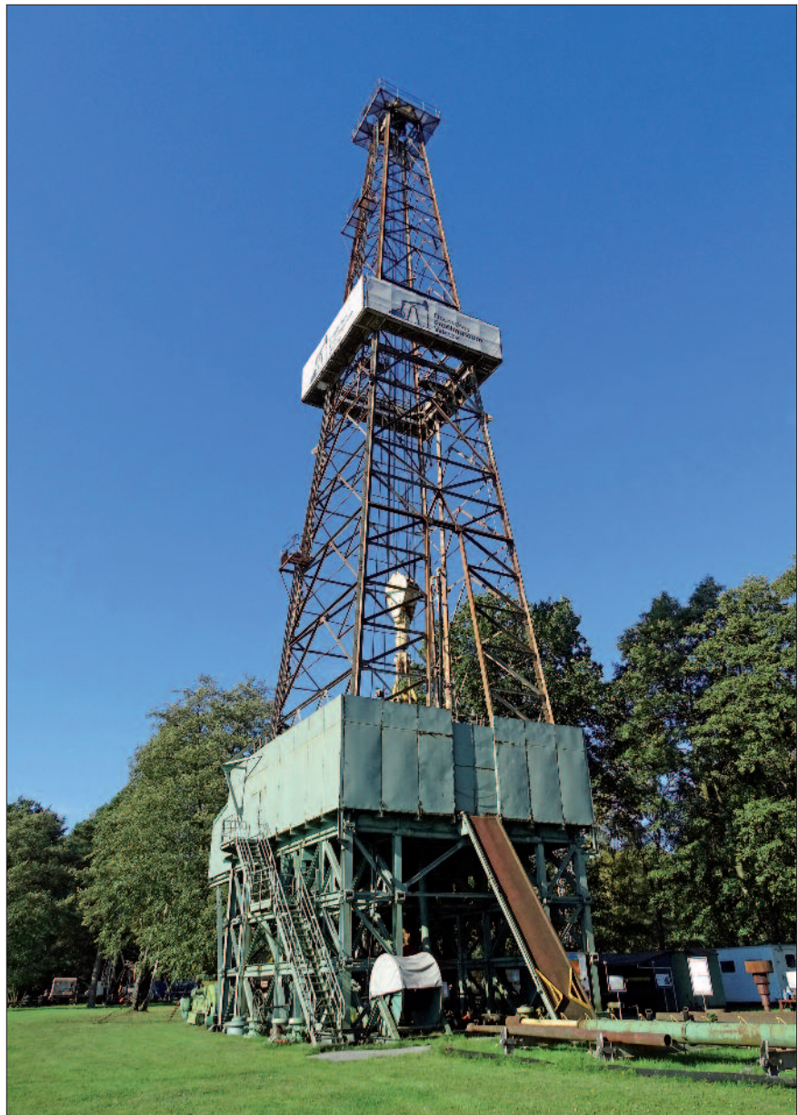
Wietzes Wahrzeichen: Der 54 Meter hohe Bohrturm auf dem Freigelände.
