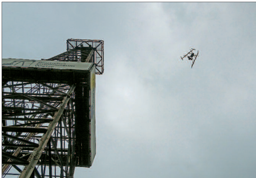
Befliegung des großen Bohrturms im Juli 2015 zur Dokumentation mit einem Oktokopter. Fotos (2): Stephan A. Lütgert/DEW
