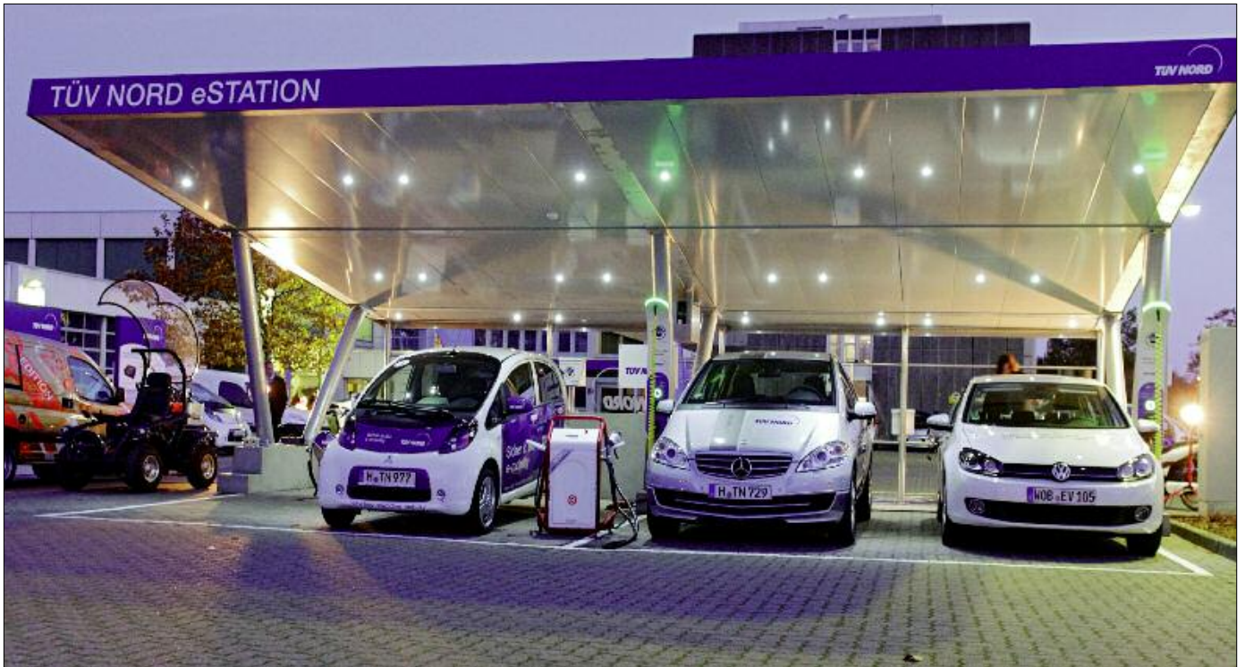
An der Ladestation des TÜV Nord für Elektrofahrzeuge kann jeder kostenlos Strom tanken.
