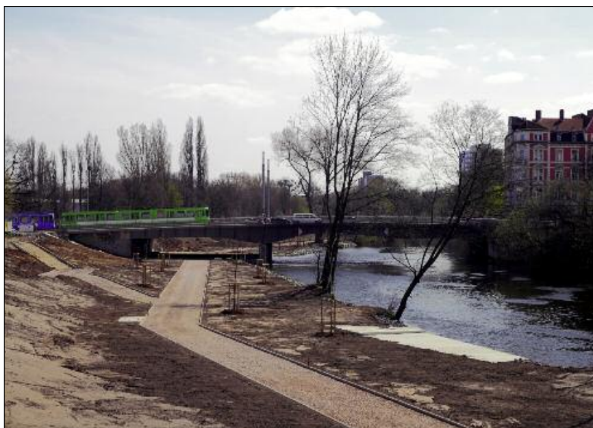
Viele Bäume mussten weichen: Neuer Hochwasserschutz am Ihmeufer in Linden vor der Benno Ohnesorg Brücke.
