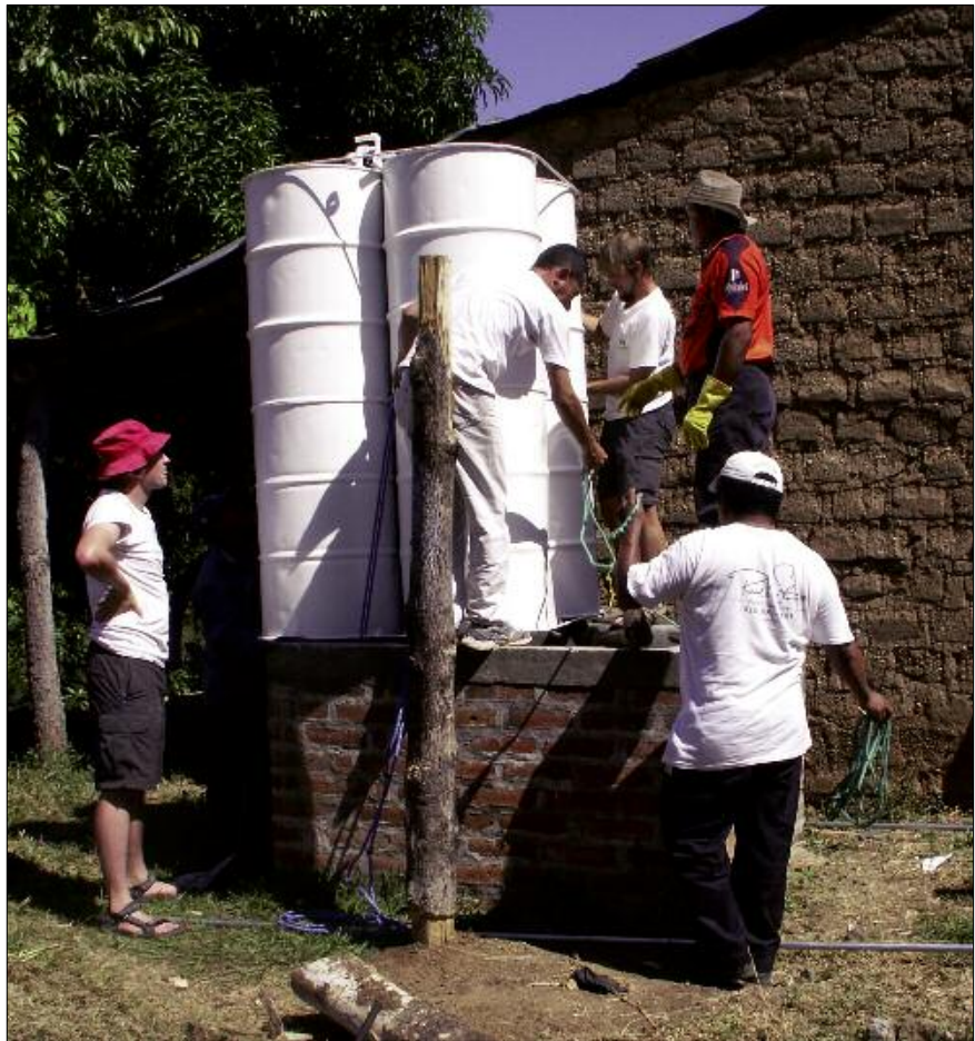
Einbau des Gasspeichers in die Anlage.
