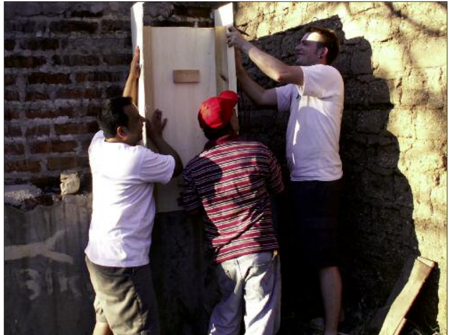
Alle helfen mit bei der Schalungskonstruktion für die Zulaufleitung der Biogasanlage.
