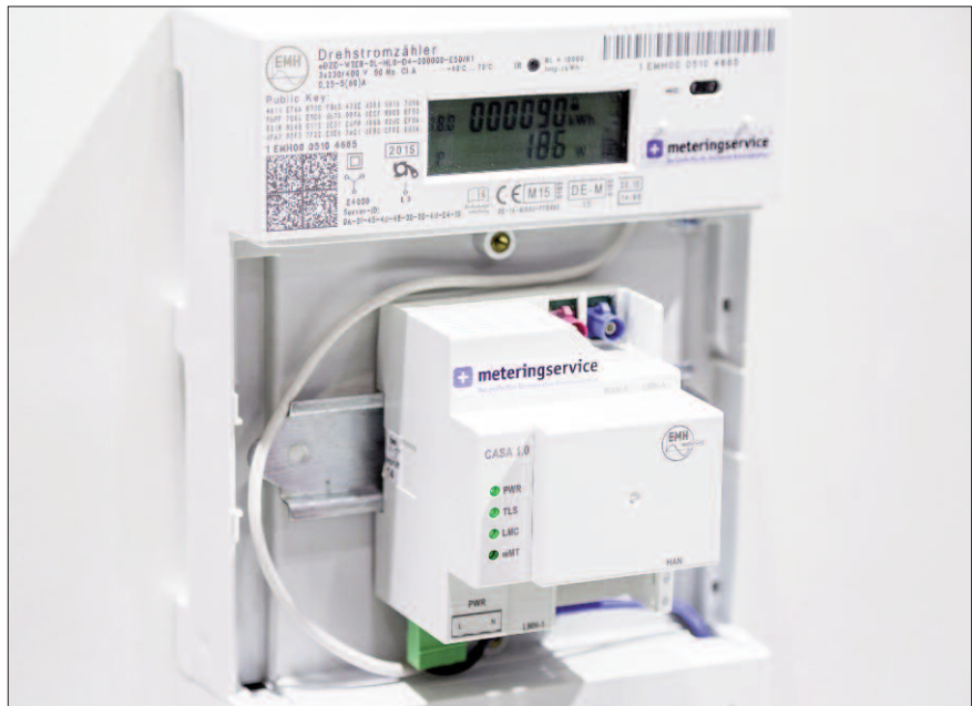
Intelligentes Mess-System nach Messstellenbetriebsgesetz, bestehend aus einem Basiszähler mit einem eingesetzten Smart-Meter-Gateway.
