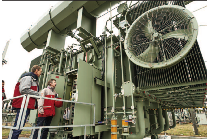
Inbetriebnahme des 150 MW PST-Sondertransformator mit Leistungsregelung im Umspannwerk Stöcken. Fotos (2): enercity
