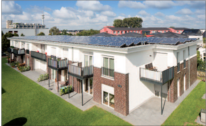
Eines der vier Gebäude mit Photovoltaik-Anlage.
