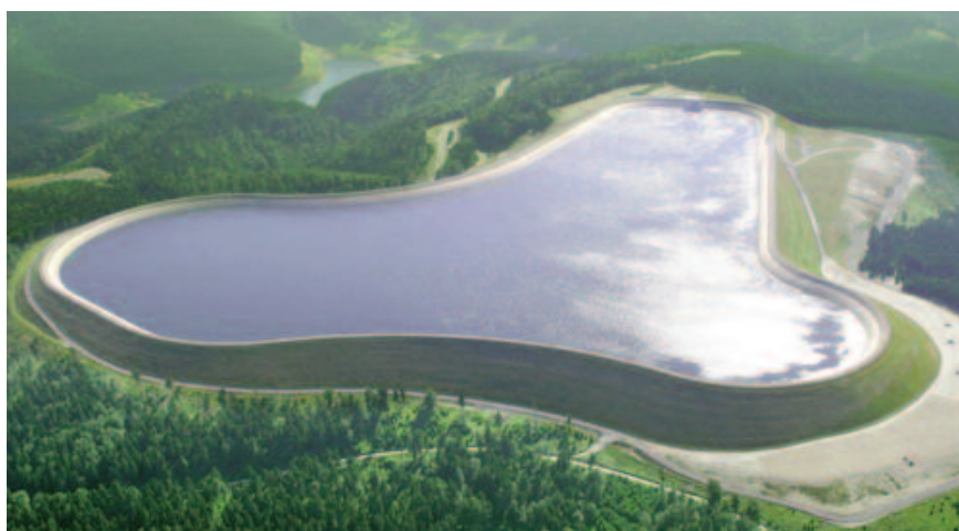
Draufsicht auf das größte Pumpspeicherkraftwerk Deutschlands in Goldisthal/Thüringen mit 1060 MW und einer maximalen Speicherzeit für diese Leistung von circa acht Stunden. Foto: Vattenfall
