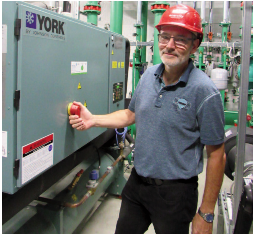
Jürgen Hahn zeigt Teile der Kühlanlage des Batteriespeichers.
