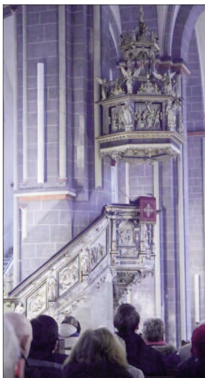
Aus architektonischen Gründen wurde der Lautsprecher auf Höhe des Kanzeldeckels angebracht.
