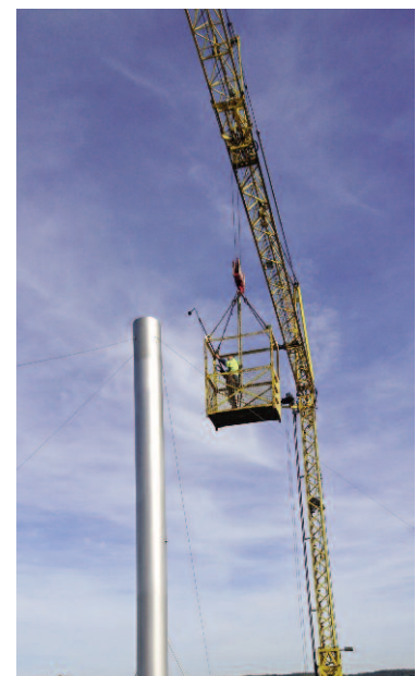
Messung von Industrielärm an einer Kaminmündung.
