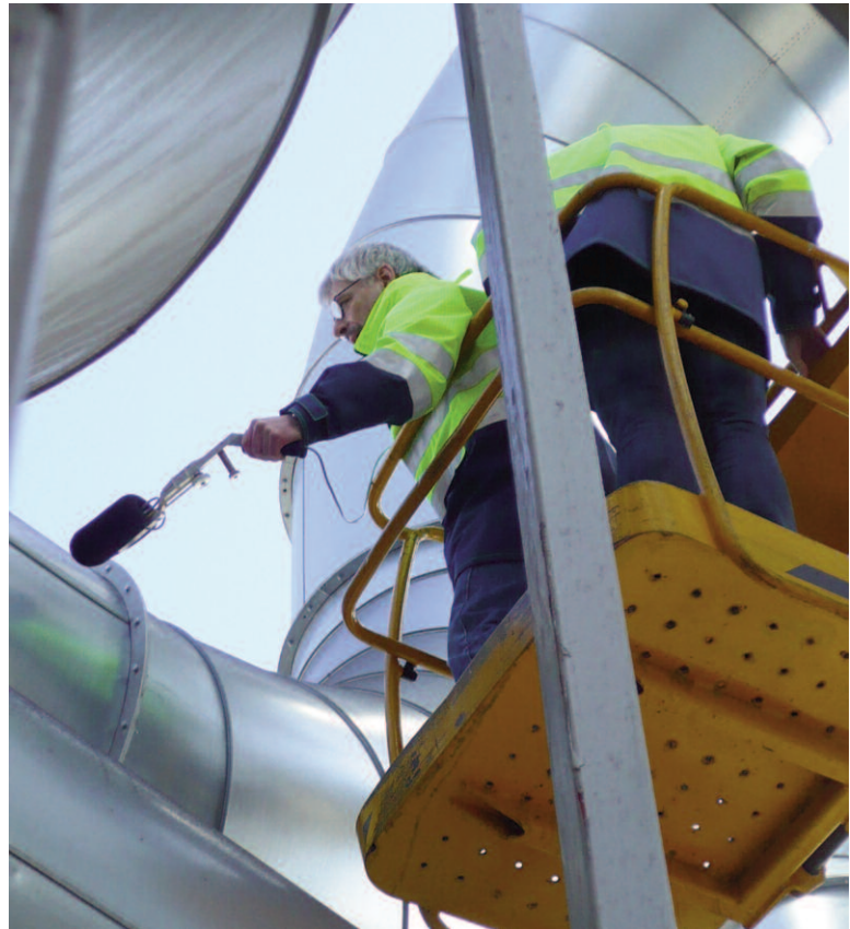
Schallmessungen zur Maschinenakustik an einer Rohrleitung.
