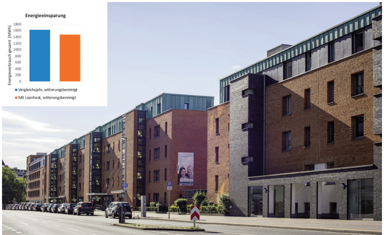
Mit Fernwärme versorgte Ostland-Siedlung des Pilotprojekts in Hannover-Linden. Oben links eine Darstellung der Energieeinsparung im Vergleich der Heizperioden 2018/2019 mit 2019/2020. Quelle (2): enercity
