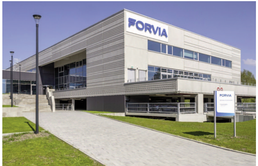
Die neue Forvia-Zentrale in Marienwerder.
