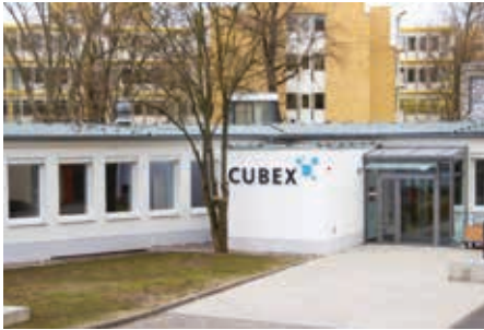
Gebäude des CUBEX auf dem Campus der Universitätsmedizin Mannheim; Foto: CUBEX
