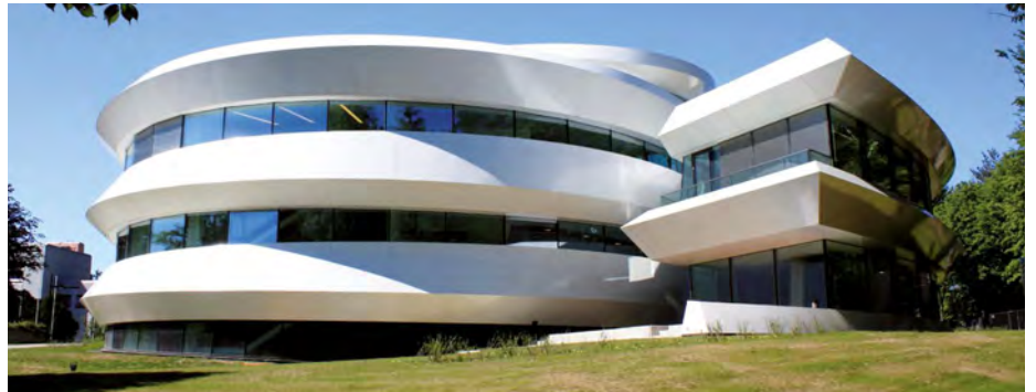
Das Haus der Astronomie. Die Architektur ist fast maßstabsgetreu einer Galaxie nachempfunden.
