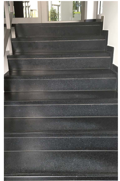
Entspricht der Norm: Treppe im MAFINEX Foto: privat
