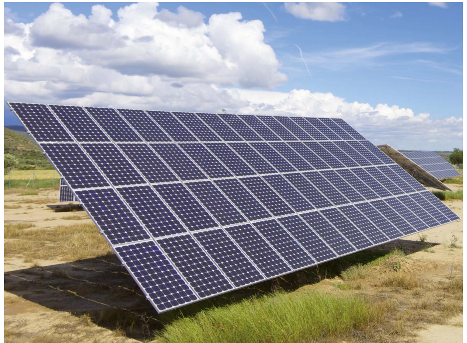
Photovoltaik Anlagen benötigen regelmäßige Wartung.
