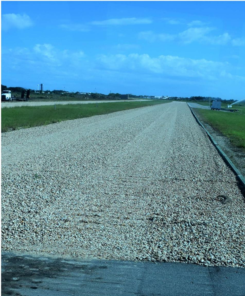
Blick auf einen „Crawlerway“ mit den Gleiskettenspuren
