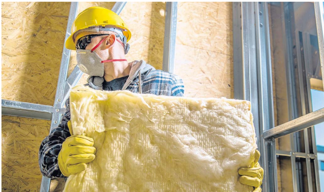
Wärmeschutz: In heißen Sommermonaten genügt der gesetzlich vorgeschriebene Dämmschutz allein nicht. Häufig kommen ineffiziente Kältegeräte zum Einsatz. Wärmepumpen oder Luft-Erdwärmetauscher wären die bessere Alternative. Foto: mauritius images / Tomasz Zajda / Alamy
