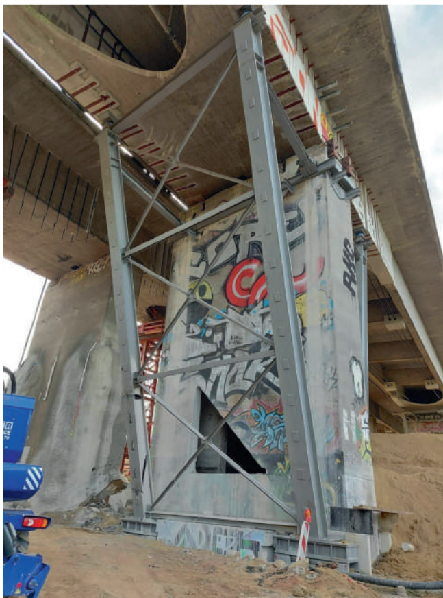
Nordbrückenpfeiler mit Y-Verstärkung Lochung des Pfeilers als Sprengmaßnahme
