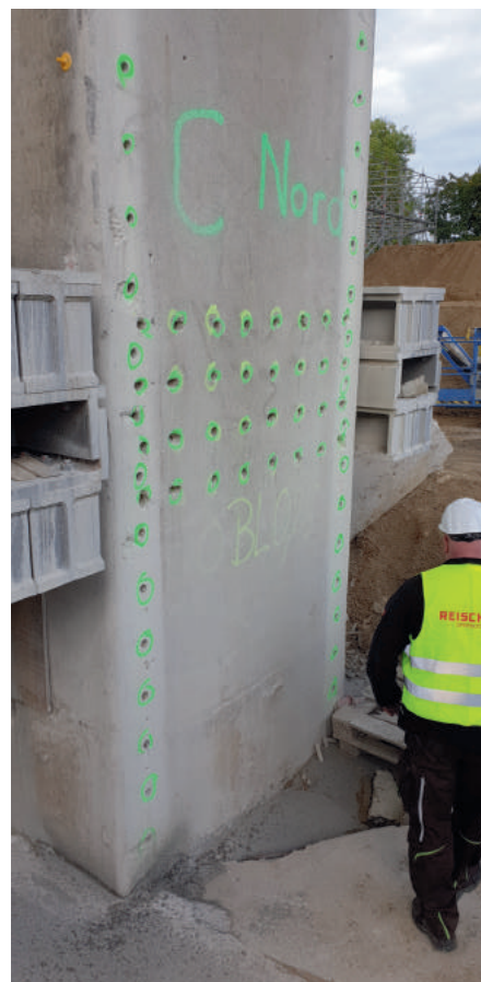
Bohrlochbild an Nordpfeiler
