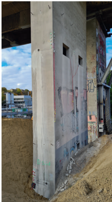
Pfeilerschwächung der Nordbrücke unten und mittig für Vertikalkollaps
