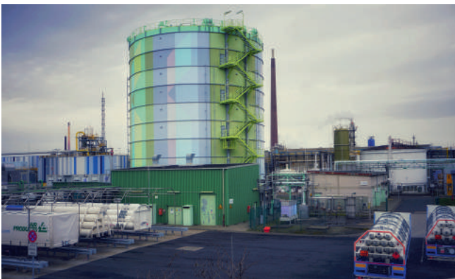
Wasserstoffzentrum mit Gasometer
