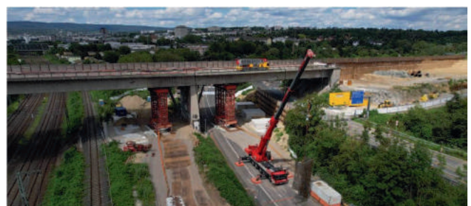
Gitterstützen beidseitig am gefährdeten Pfeiler
