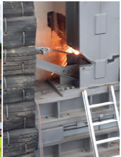
Festlegung der Knickstelle durch Schwächung der Y-Streben
