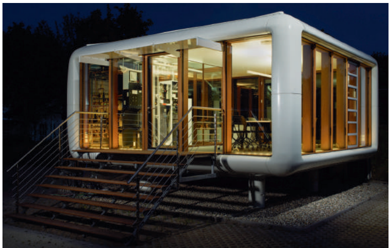
Reallabor an der TH Bingen für Energie- und Versorgungstechnik
