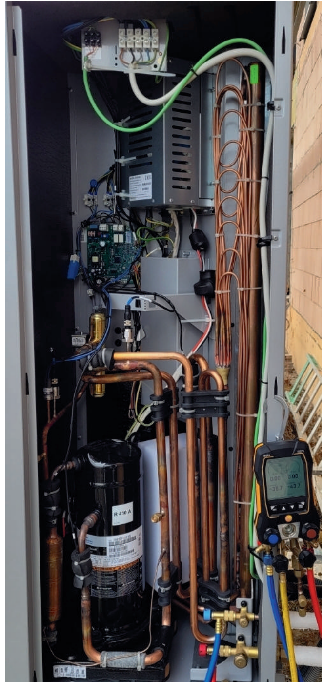
Außereinheit während der Evakuierungsmaßnahme zur Befüllung mit Kältemittel.
