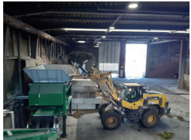
Biogas Anlage Wicker
