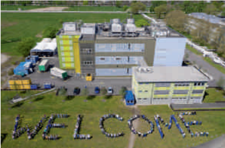
Produktionsbetrieb AC2 am Standort Frankfurt
