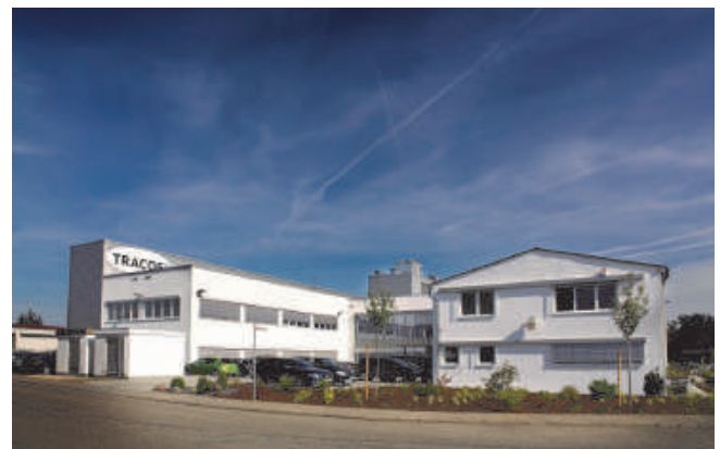
Firmengebäude in Nieder-Olm
