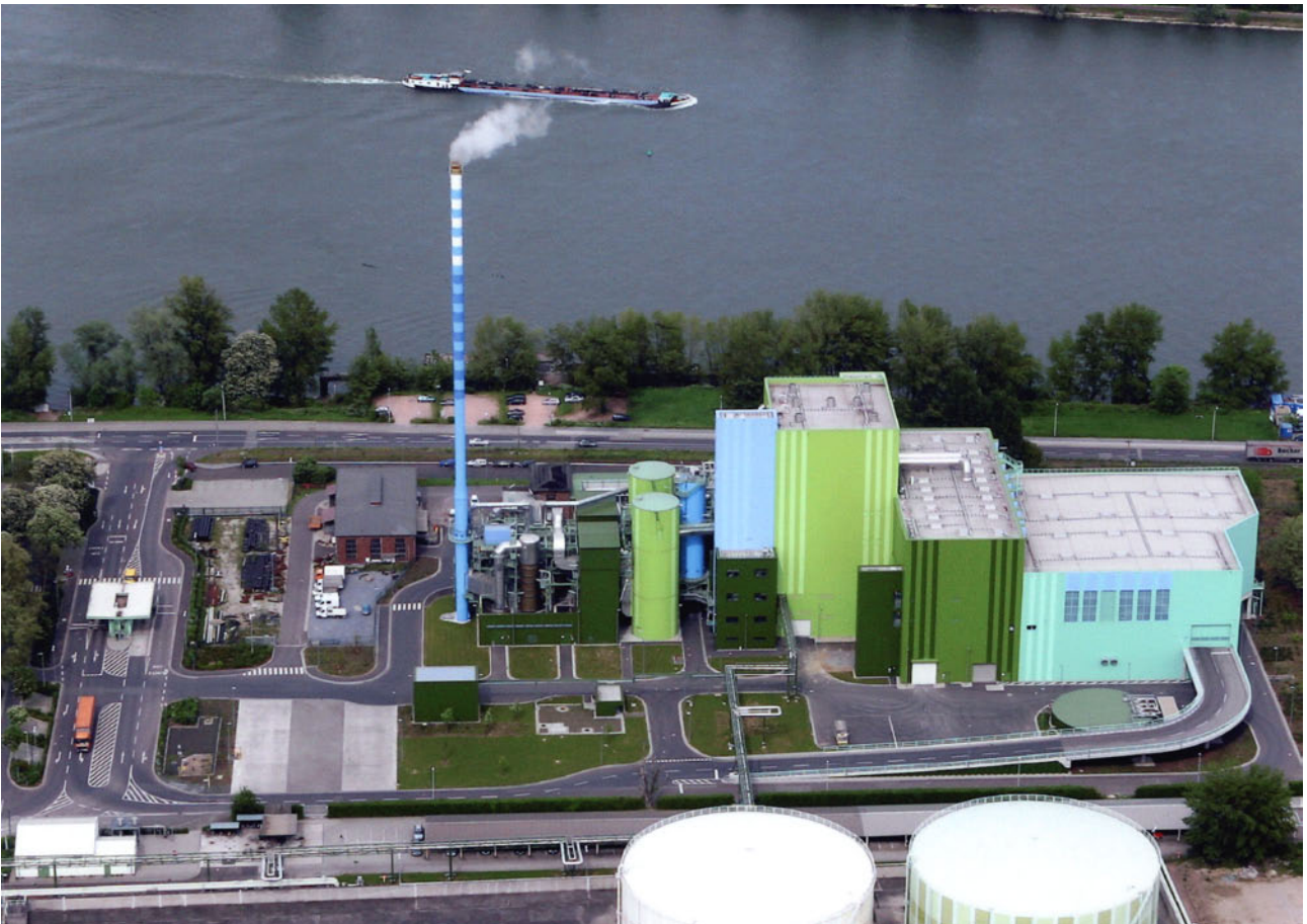
Müllheizkraftwerk Mainz von Süden gesehen. Die wichtigsten Komponenten: (von rechts): Entladehalle, Müllbunker, Kesselhaus, Abgasreinigungsanlage, Schornstein, Pforte mit Wiegeeinrichtung
