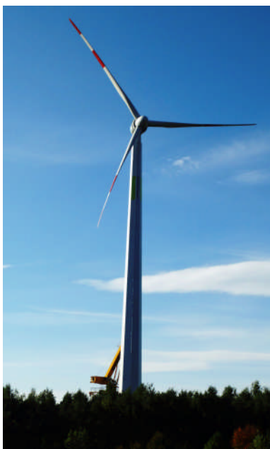
H=100 Meter: Der weltweit erste Holzturm für eine Windkraftanlage
