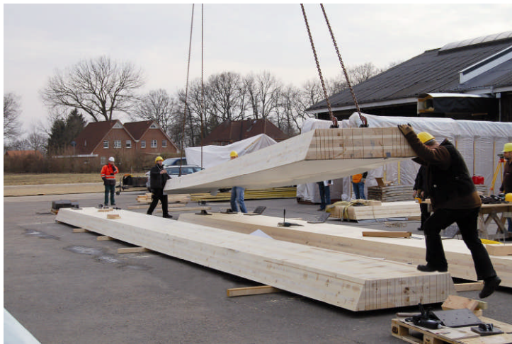
Neuartige Bauelemente: Brettsper Holzplatten mit trapezförmigem Querschnitt, zugeschnitten für den Turm einer Windkraftanlage. Abmessungen: Länge bis zu 15 m, Breite bis zu 2,90 m, Dicke 30 cm
