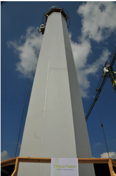
Fertiggestellt: Der 25 Meter hohe Turmabschnitt zur Erprobung der Montage Bild: TimberTower
