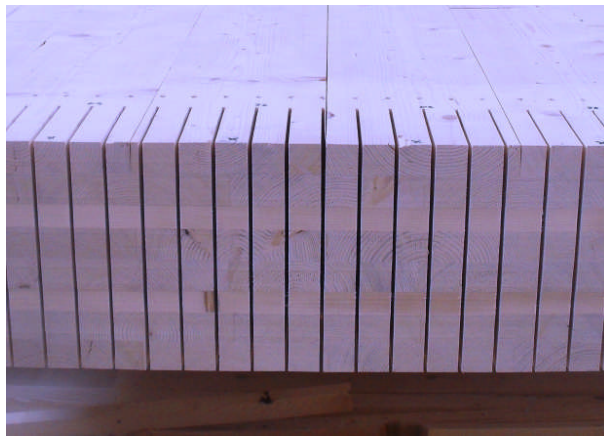
Die Verbindung zwischen den Bauelementen: In die Schlitzte werden Lochbleche eingesteckt, der Klebstoff wird über vordefinierte Öffnungen eingepumpt und härtet aus. Bild: TimberTower
