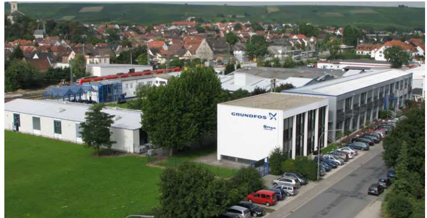
1962 gebaut, 2008 aufgestockt- Der Hauptsitz in Bodenheim: Produktionsstätte mit Konstruktions- und Entwicklungsabteilung und Kompetenzzentrum für Hygienetechnik der Firma Hilge GmbH & Co. KG, Sitz der Grundfos Building Services Niederlassung Frankfurt und Sitz der Grundfos Industrie Division.
