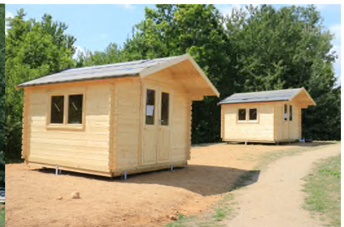
Fertige Häuser: Es handelt sich um Blockbohlen-Häuser, Typ Jamaica. Blockbohlenstärke 28 mm. Länge 3 m, Breite 3 m, Geschosshöhe 2,56 m, umbauter Raum 25,71 m 3 . Bild: M. Schneider
