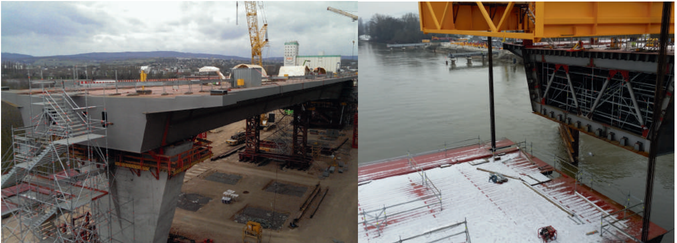
Lückenschluß zwischen Verbund und Stahlkonstruktion durch Zwischenstück
