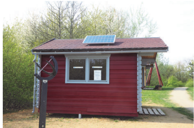
Holzhaus mit Solaranlage und Zisterne
