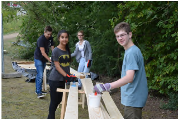
Aufbauarbeiten: Mit großem Eifer führten die Schüler die für sie ungewohnten Arbeiten durch. Hier die Vorbereitung zur Montage der Seitenbretter. Bild: Hildegund Klockner
