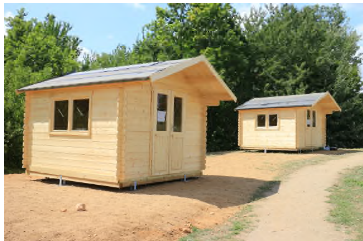
Fertige Häuser: Es handelt sich um Blockbohlen-Häuser, Typ Jamaica. Blockbohlenstärke 28 mm. Länge 3 m, Breite 3m, Geschosshöhe 2,56 m, umbauter Raum 25,71 m 3 . Bild: M. Schneider
