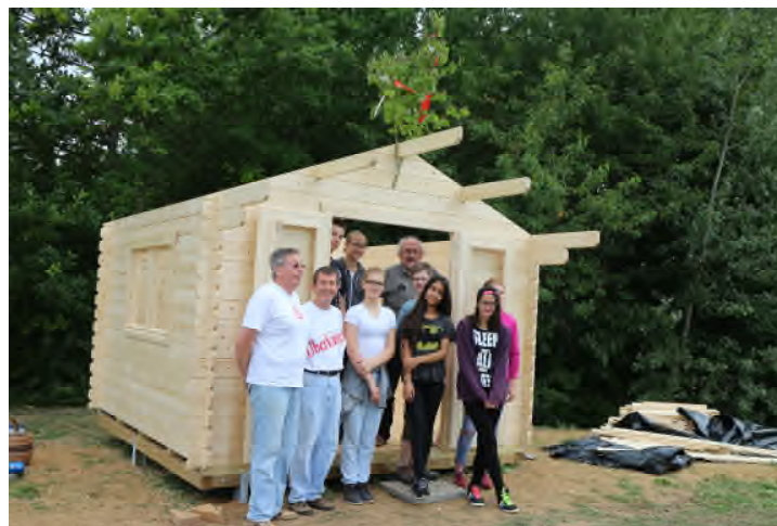
Richtfest: Auch bei dem Bau eines kleinen Holzhauses darf dieses Fest nicht fehlen. Die VDI-Mannschaft und die Schülerinnen und Schüler vor dem Haus 1, das in zwei Tagen gemeinsam errichtet wurde. Bild: Schneider
