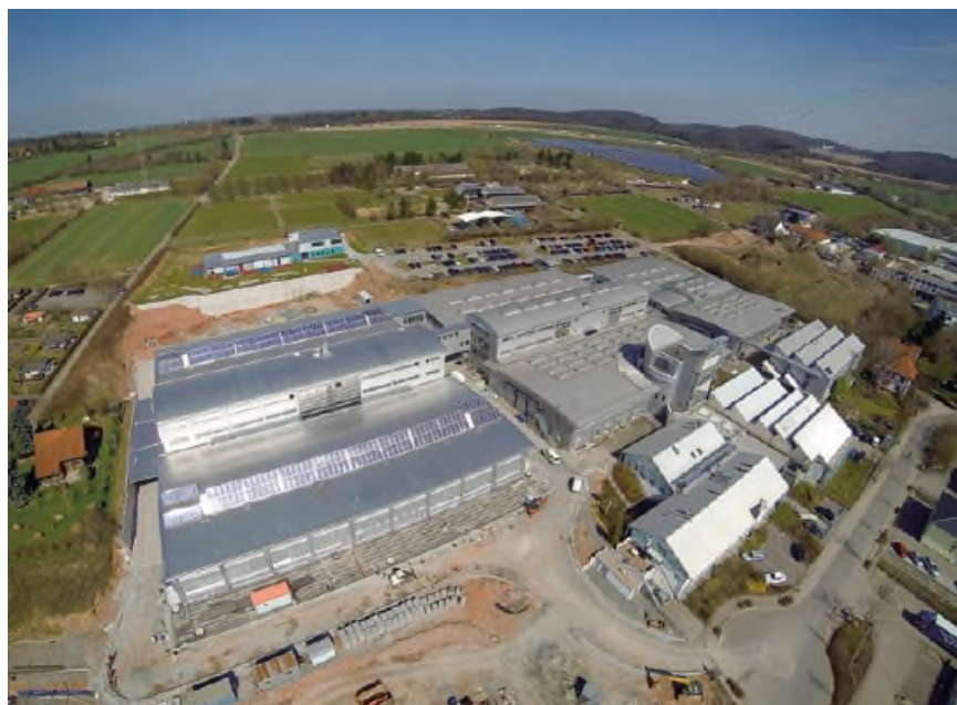
Nachhaltig und hocheffizient 3: Der mit modernster Gebäudetechnik ausgestattete Neubau (links), der Altbau (rechts) und eine Fotovoltaik-Anlage (hinten rechts) werden durch Smart TOM zu einer energetischen Einheit zusammengefasst, die einen mittelständischen Produktionsbetrieb völlig energieautark macht. Bild: Wipotec
